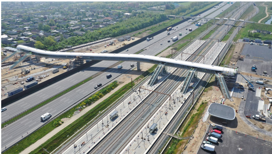
Gang bro til den nye station Køge Nord.
